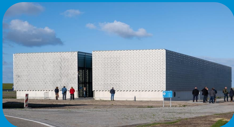
Siemens Trafogebouw - Breezanddijk
